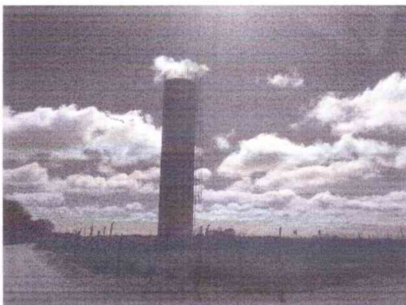
Foto 06 - Reservatório Elevado Existente de 44 m 3 (Mata Grande)
