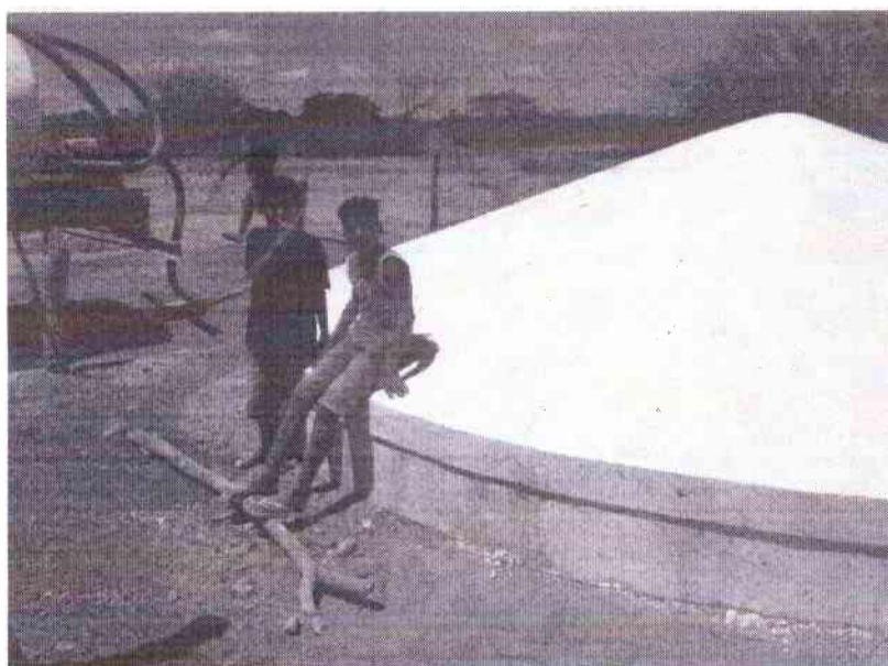
Foto 04 - Reservatório Semienterrado existente de 50 m 3 (Pedro Cordeiro)
