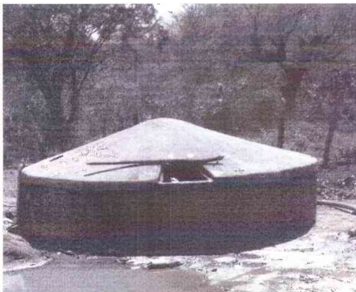
Foto 05 - Reservatório Semienterrado existente de 16 m 3 (Betânia)
