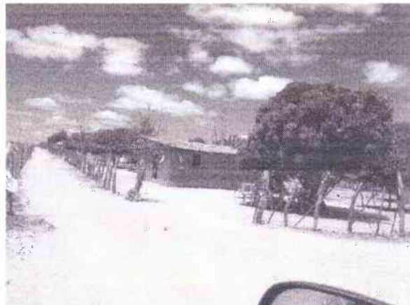
Foto 11 - Ruas Sem Pavimentações
