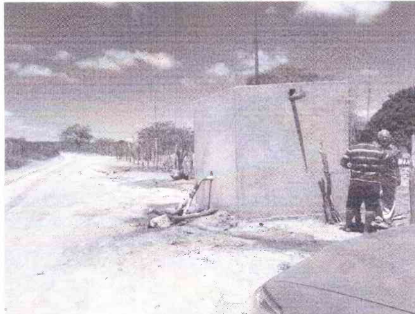
Foto 03 – Poço da Serra do Catolé/Tataíra
